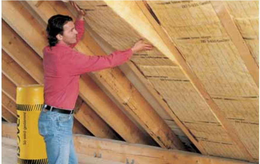
Mineralwolle wird häufig zum Dämmen verwendet.
