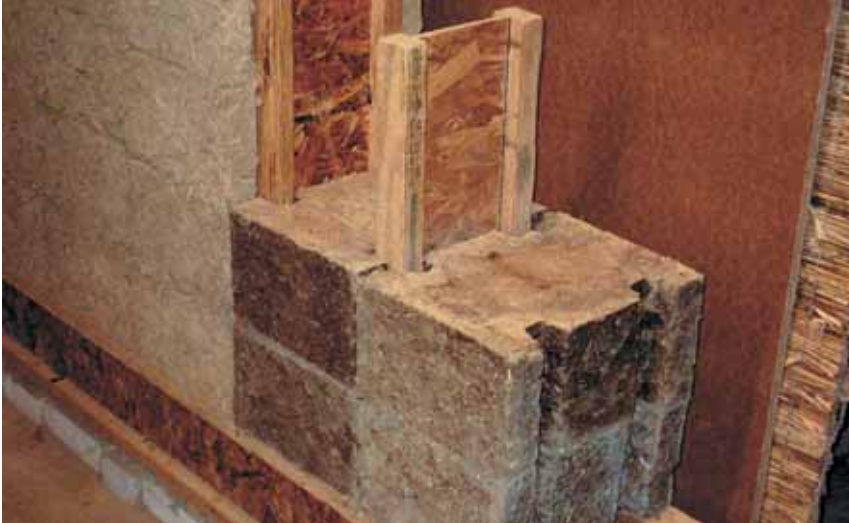
Wand aus großformatigen Strohleichtlehmsteinen auf einem innen liegenden Holzträgerwerk.
